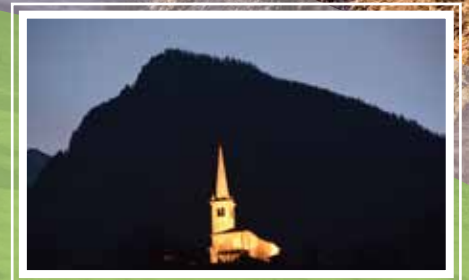
NUOVA ILLUMINAZIONE DEL CAMPANILE
