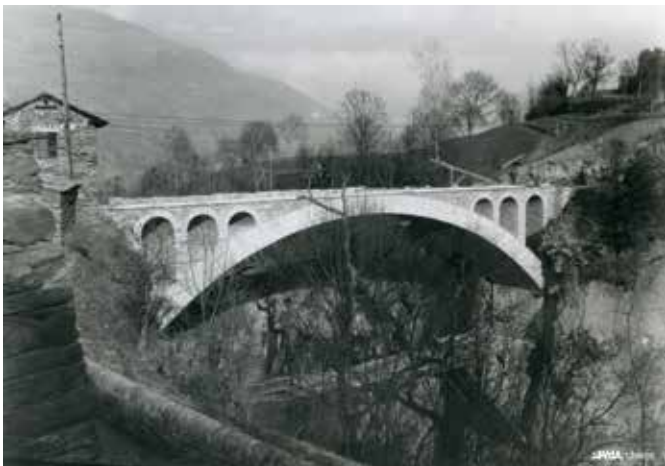
1916 - Le pont est presque achevé : on construit les garde-corps 4
