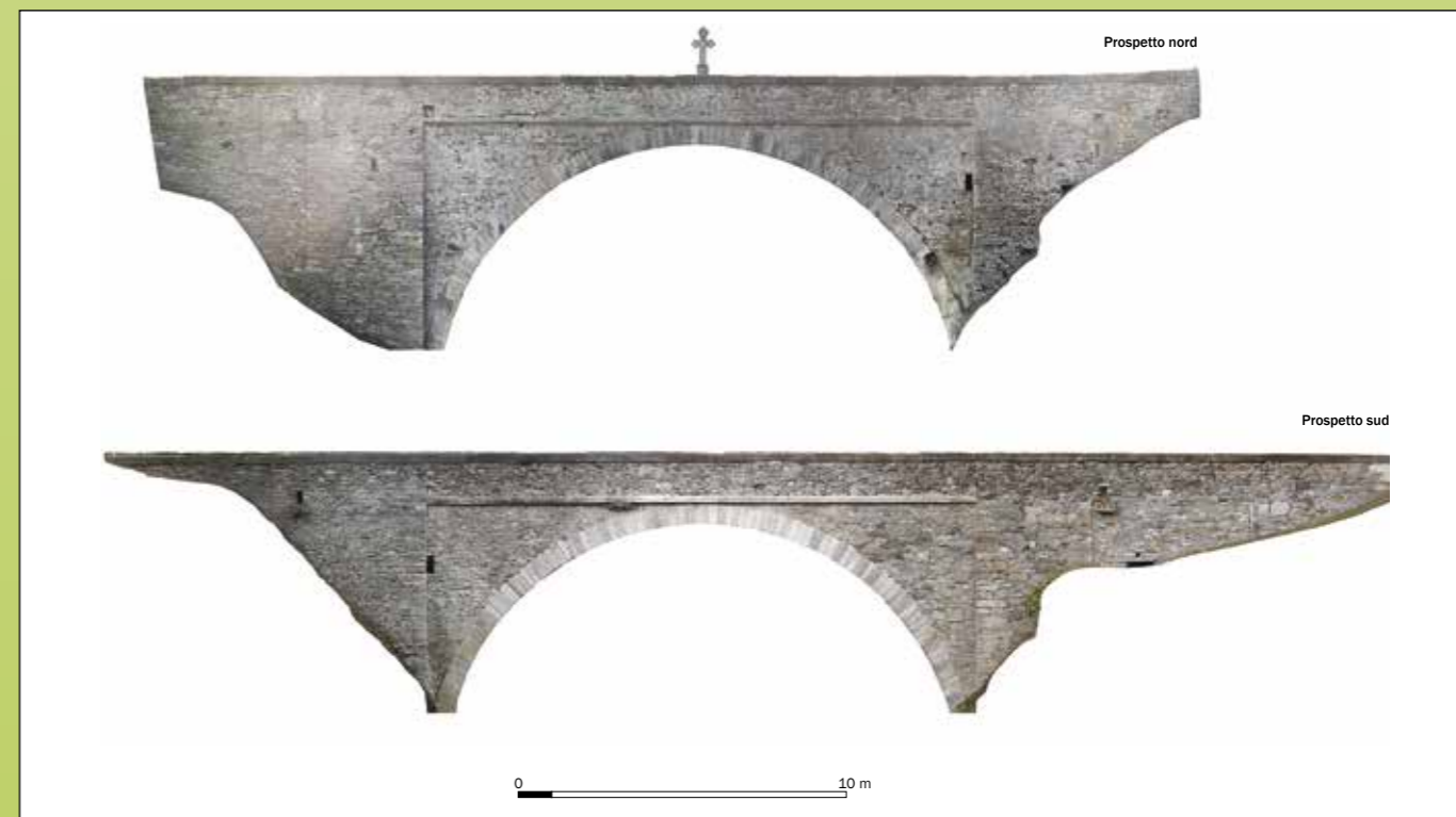
2a.-b. Ortofoto dei prospetti nord (in alto) e sud (in basso) del ponte. (Vertical Eye Drone Solutions)
