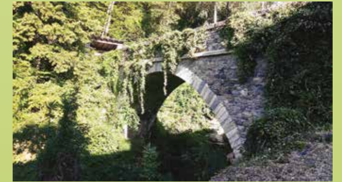
6. Il ponte prima delle operazioni di pulizia dalla vegetazione infestante. (Tethys Srl)(Tethys Srl)
